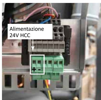
②b Morsettiera B2 – HCC – Segnale unità interna
