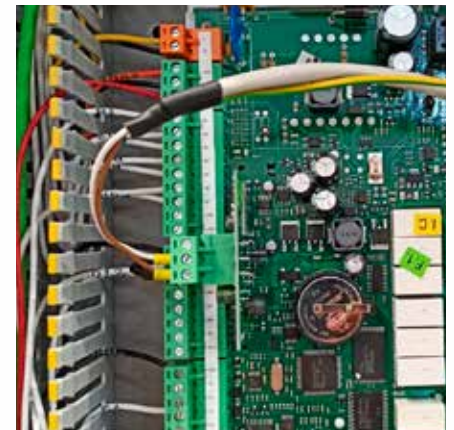
⑥b Particolare connessione \mu PC BMS
