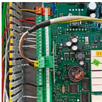
⑦b Particolare connessione \mu PC BMS
