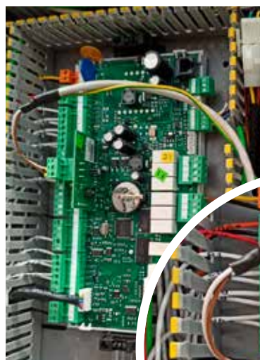
⑦b Detail Verbindung Platine µPC BMS
