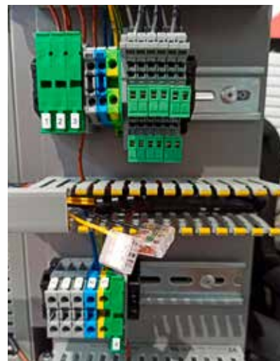
③ Detail Kabelkanal
