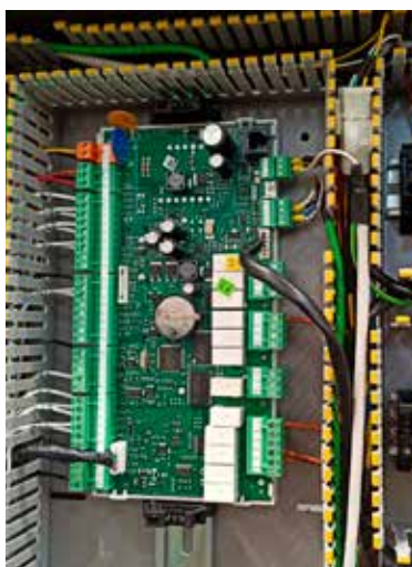
⑦a Detail Verbindung Platine µPC PLan
