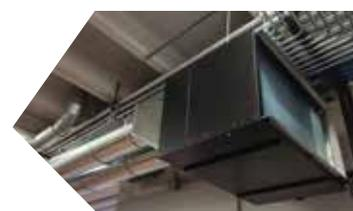
Pompa di calore aria/aria per la climatizzazione di spazi industriali
