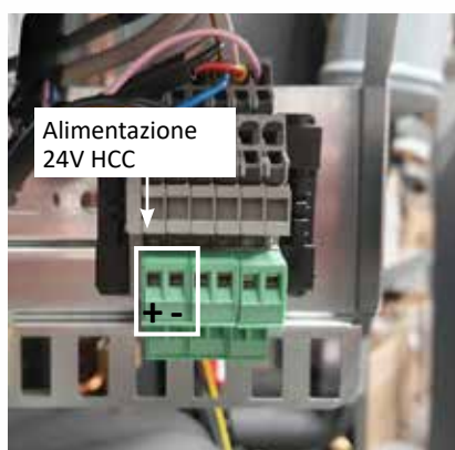
②b Morsettiera B2 – HCC – Segnale unità interna
